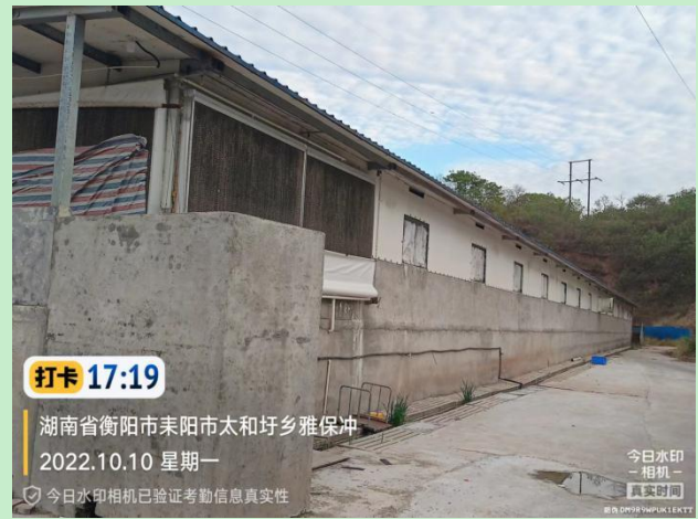
一栋猪舍建设现状
