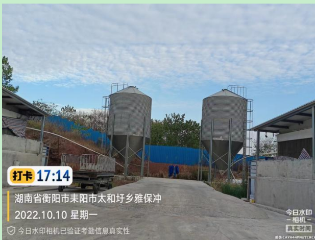
二、三栋猪舍料塔
